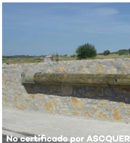
Conexión G/G+ en muro bajo 800 460
